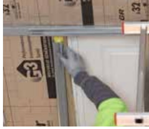
3 POSE DE LA FOURRURE HORIZONTALE
