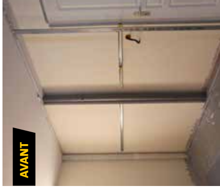
Tuyaux en angle et en décroché de mur à isoler.
