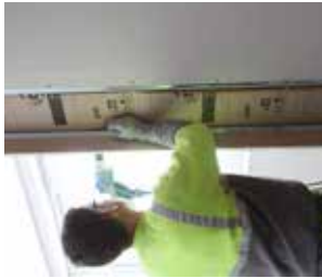
3 VISSAGE LISSE D'ANGLE
