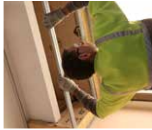
6 RÉGLAGE DE LA FOURRURE D'ARÊTE
