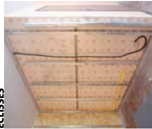
6 OSSATURE AVANT PROLONGEMENT DES ÉCLISSES
