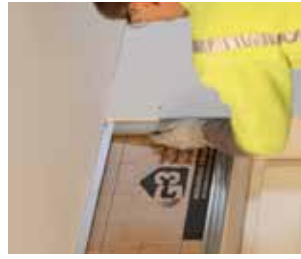
6 POSE DE LA FOURRURE D'IMPOSTE
