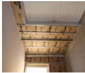
7 VUE FOURRURES POSÉES
