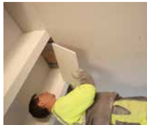
7 POSE PLAQUES DE PLÂTRE ENTRE SOLIVES
