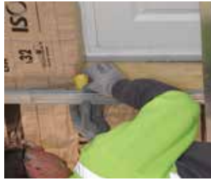
2 POSE DU CONNECTOR OPTIMA
