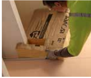
4 POSE DE L'ISOLATION
