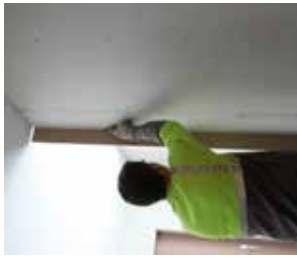
4 DÉCOUPE PAREMENT SUR L'ANGLE
