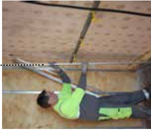
4 POSE DES FOURRURES VERTICALES
