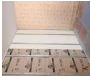
5 POSE D'UNE FOURRURE D'ANGLE
