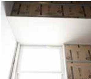
2 PAREMENT SUR UN CÔTÉ
