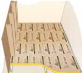
3 POSE DE L'ISOLANT
