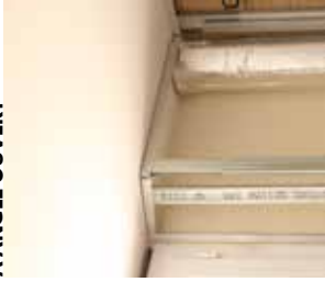
4 SEGMENTS DE LISSES CLIP'OPTIMA FIXÉS À ANGLE OUVERT
