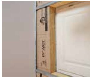
1 POSE DE L'ISOLANT SUR L'IMPOSTE
