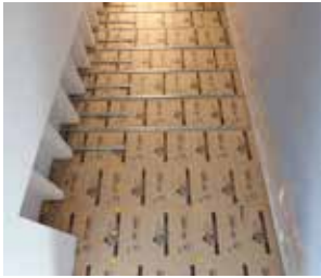
4 CALEPINAGE DES FOURRURES
