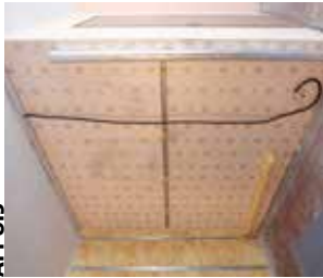
3 POSE DES FOURRURES HORIZONTALES ET APPUIS
