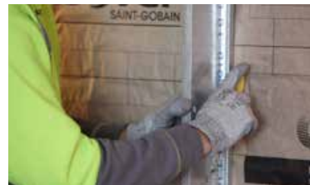
Position finale de la clé d'appui Optima 2 après verrouillage
