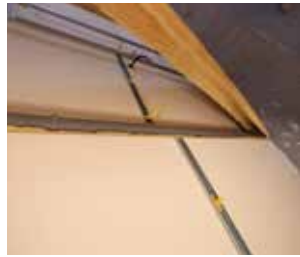
6 POSE DE L'ISOLANT GR 32
