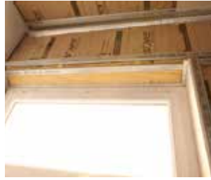
8 VUE DE L'OSSATURE DE TABLEAU
