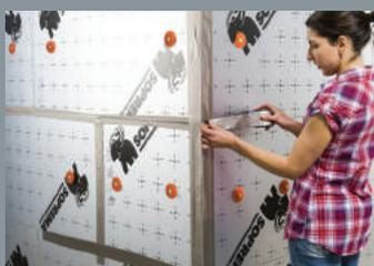
2 Poser l'ossature support de bardage directement sur l'isolant. Les tasseaux de l'ossature bois sont fixés selon un entraxe de 600 mm maximum. Les joints de panneaux peuvent être pontés par un adhésif aluminium afin d'améliorer l'étanchéité à l'air du système.
