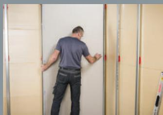
5 La jonction des panneaux isolants est traitée avec du ruban adhésif. Poser les plaques de plâtre et faire les finitions.
