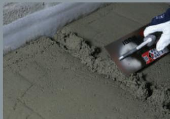
Au minimum 15 jours après la coulée et après vérification du taux d'humidité du béton léger, le revêtement de sol peut être posé et/ou collé :
