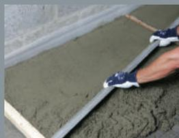
Appliquer le béton en une couche de minimum 5 cm et l'égaliser à l'aide d'une règle.
