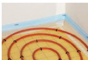
Isolant sous plancher hydraulique
