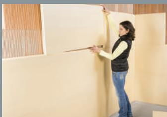
1 Les panneaux isolants sont mis en œuvre par simple emboîtement entre le sol et plafond. Les découpes sont faites à la scie égoïne.
