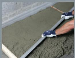
Appliquer le béton en une couche de minimum 4 cm et l'égaliser à l'aide d'une règle.
