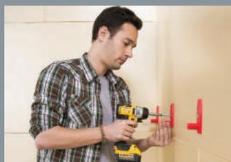
2 Fixer l'Appui intermédiaire de contre-cloison sur le panneau.
