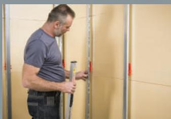
3 Fixer mécaniquement les lisses hautes et basses\* et clipser la fourrure sur l'appui.
