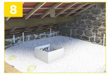
Soufflez la laine en commençant par le côté opposé à la trappe. Pour un soufflage homogène gardez le tuyau de la machine Ma Comblissimo 2 en position horizontale. Référez-vous à l'étiquette du produit pour connaitre l'épaisseur à souffler en fonction du niveau d'isolation que vous souhaitez obtenir.
