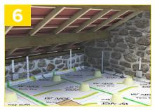
Mettre en place les piges graduées pour le contrôle de l'épaisseur de laine soufflée.
