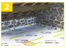
Déroulez la membrane Vario® Xtra sur le plancher bois (face imprimée visible) en laissant 10 cm en périphérie du mur. Posez les autres lés de la membrane avec un recouvrement de 10 cm sur le lé précédent. Le quadrillage de la membrane, tous les 10 cm, vous aidera à respecter cette mesure.
