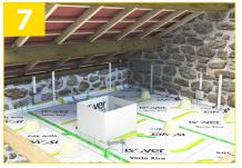
Installez l'entourage de la trappe de visite et faire remonter les 10 cm de membrane laissés à cet effet sur son contour. Assurez son étanchéité en réalisant un cordon de mastic entre la membrane et l'entourage sur toute la périphérie puis posez l'adhésif aux jonctions.
