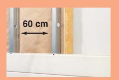
La *Pose sur ossature bois* ou *ossature métallique* facilite la mise en place d'un isolant.
