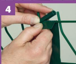
4 Plier la lamelle et verrouiller avec un clip.
