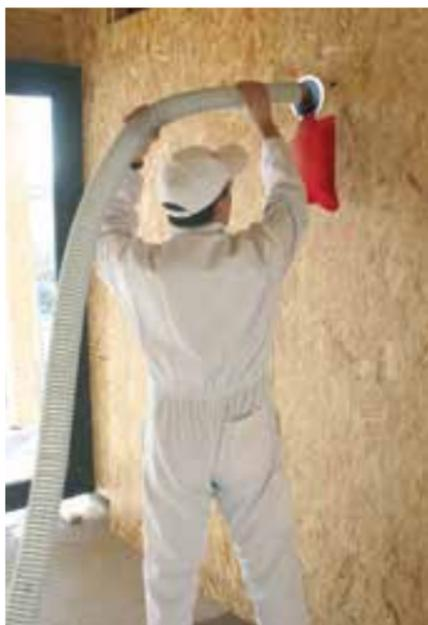
L'insufflation consiste à injecter la **Ouate de Cellulose**, à sec, à l'aide d'une machine dans des caissons de parois verticales.
