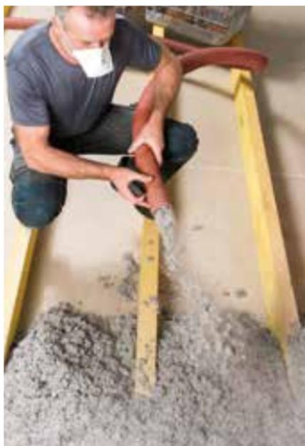
Le soufflage consiste à épandre la **Ouate de Cellulose**, à sec, à l'aide d'une machine sur les planchers de combles non-aménageables.
