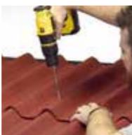
Fixez les plaques en utilisant les vis universelles au sommet des ondes, entre les guides de recouvrement. Attention de ne pas écraser les ondes !
