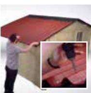
Pour la deuxième rangée : commencer la pose avec une demi-plaque et aligner les guides de recouvrement pour une étanchéité parfaite.
