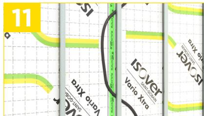
Passez les gaines électriques dans l'espace technique entre la fourrure et la membrane.
