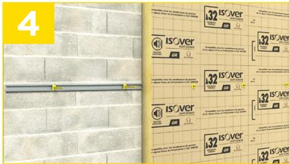
Découpez l'isolant murs selon la hauteur sol-plafond + 1 cm. Embrochez-le sur les appuis Optima<sub>2</sub>, la face kraft vers vous. Positionnez bien l'isolant mur bord à bord.
