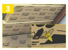
Posez la première couche d'isolant combles aménagés entre chevrons puis embrochez la seconde couche d'isolant combles aménagés sur les tiges de suspentes\*
