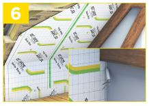
Pour assurer l'étanchéité à l'air, jointoyez les lés avec l'adhésif Vario® de votre choix puis collez au mur avec le mastic, les 10 cm de la membrane laissée sur toute la périphérie du comble sur les murs, le sol et le plafond.
