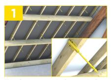
Fixez les suspentes Intégra<sub>2</sub> ou Intégra<sub>2</sub> réglable sur la charpente à l'aide de vis à bois (2 vis dans les trous les plus larges pour le réglage et une 3ème vis pour bloquer) Installez les suspentes en quinconce, tous les 120 cm sur un même chevron pour un entraxe entre chevrons <60 cm.
