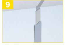
Réalisez le joint entre les plaques : garnissez le creux des bords amincis avec de l'enduit. Humidifiez la bande papier microperforée et la placer dans l'axe du joint avant de la maroufler et la recouvrir avec l'enduit.
