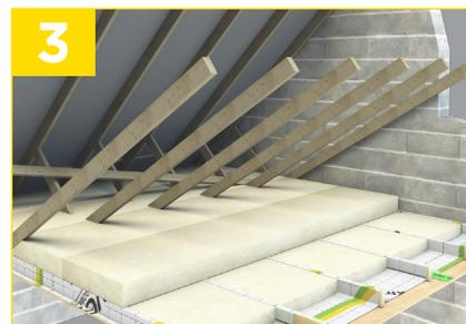
Placez l'isolant entre les solives. Dans le cas d'une pose en double couche, déroulez perpendiculairement la 2ème couche d'isolant sur la lère.
