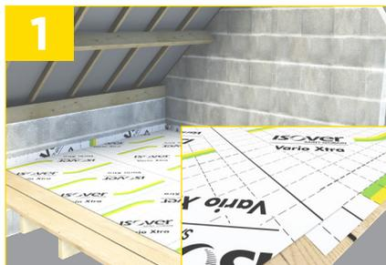
Déroulez la membrane Vario® Xtra sur le plancher bois (face imprimée visible) en laissant 10 cm en périphérie du mur. Posez les autres lés de la membrane avec un recouvrement de 10 cm sur le lés précédent. Le quadrillage de la membrane, tous les 10 cm, vous aidera à respecter cette mesure.
