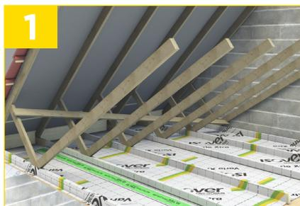
Déroulez la membrane Vario® Xtra sur le plancher bois. Laissez dépasser de 10 cm la membrane en périphérie de mur. Pour assurer l'étanchéité à l'air, jointoyez les lés avec l'adhésif Vario® de votre choix puis collez au mur avec le mastic, les 10 cm de la membrane laissée sur toute la périphérie du comble.
