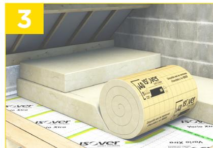
Déroulez l'isolant comble perdu et plafonds sur le plancher. Le surfacage kraft doit être côté plancher. Dans le cas d'une pose en double couche, déroulez perpendiculairement la 2ème couche sur la lère au fur et à mesure, ceci afin de ne pas marcher sur l'isolant.
