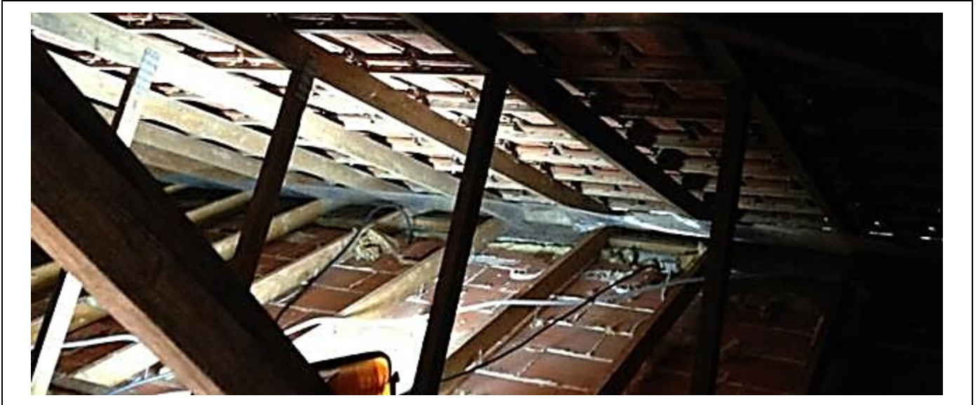
Figure 12 : Vue d'ensemble du grillage installé dans un comble à faible pente, entrée d'air par le galbe des tuiles
