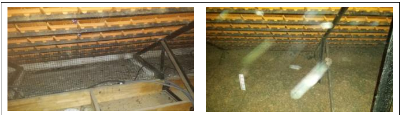
Figure 7 : Vue du grillage installé, avant (gauche) et après (droite) soufflage de la laine de roche
