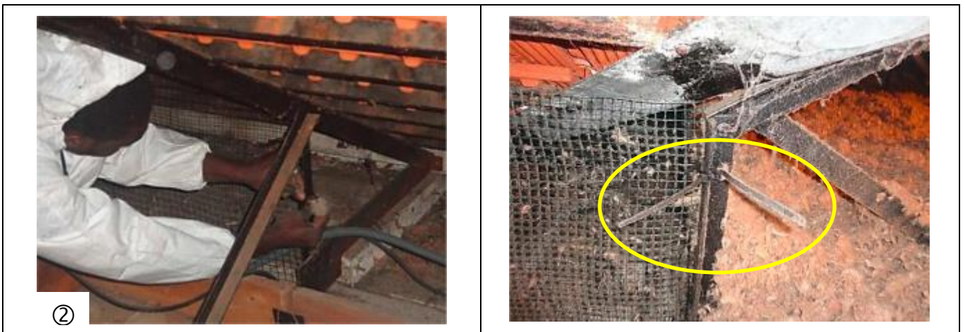
Figure 6 : Mise en œuvre du grillage sur les contrefiches (gauche) à l'aide de colliers plastiques (détail à droite)
