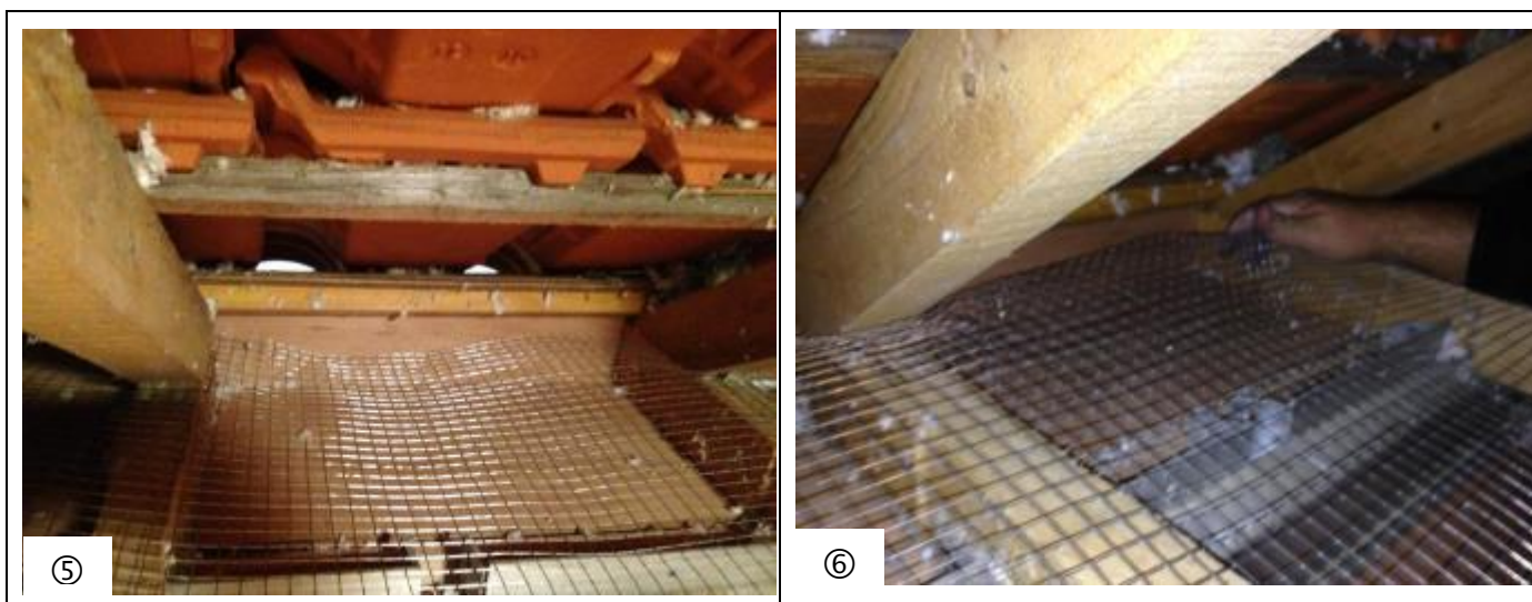
Figure 17 : Le grillage épouse le contour de la structure (gauche) et il est recourbé à la main en partie basse (droite)
