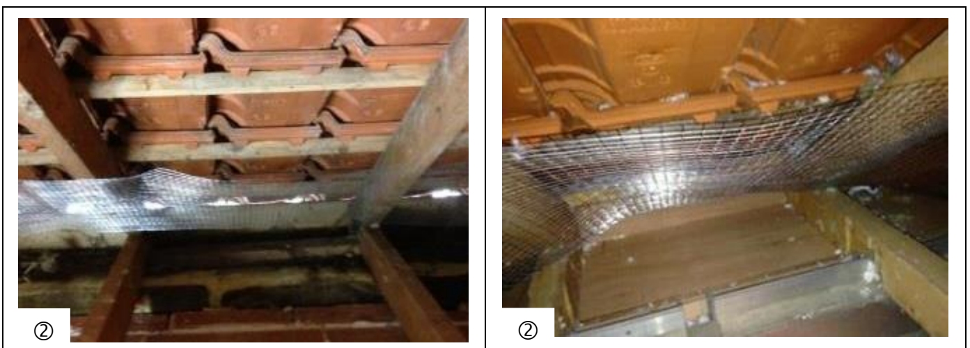
Figure 11 : Mise en place du grillage sur les arbalétriers dans un comble à faible pente, avec entrée d'air par le galbe des tuiles et présence d'entretoise et de panne sablière (gauche) et planche de rive (droite) en partie basse de la rive
