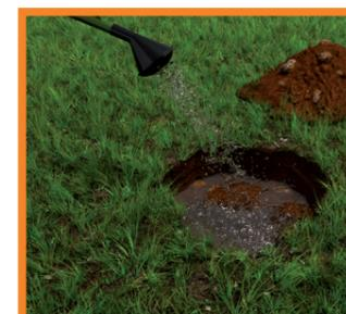
2 - Verser le béton - Positionner l'objet
