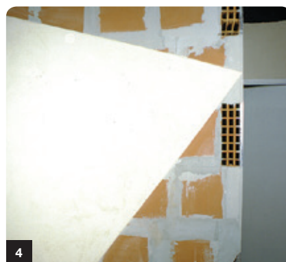
Application d'un enduit monocouche.
