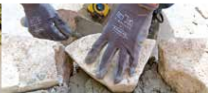
Maçonnerie de pierres
