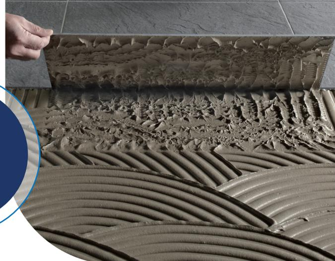
que sur une surface pouvant être recouverte par le carrelage dans un délai maximum de 20 minutes (temps ouvert). Procéder par double encollage (appliquer une couche uniforme de colle sur l'envers du carreau) lors de la pose d'un carrelage d'un format supérieur ou égal à 20 cm x 20 cm.
