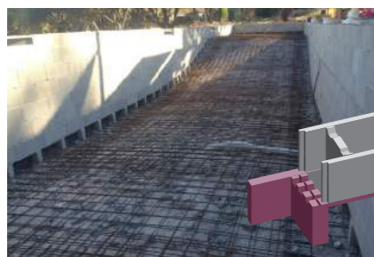
3 - Alphabloc® associé aux blocs de coffrage enduits + ferrailage.
