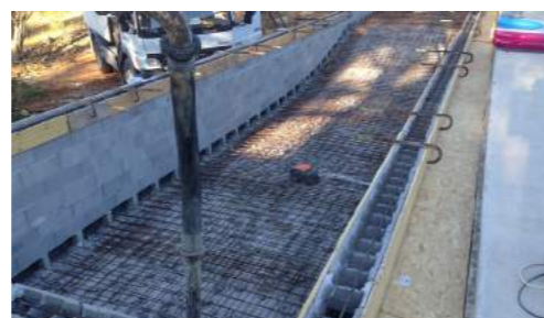
4 - Coulage du radier et des murs en une seule opération.
