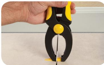
**2** Glisser une cale réutilisable jaune dans le CLIPS et l'enfoncer à l'aide la pince jusqu'à ce que les carreaux soient de même niveau.
