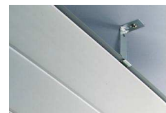
Suspension métallique Pour réduire la hauteur de plafond de 15 cm.
