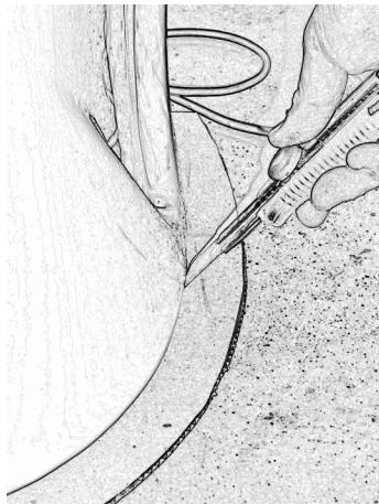
3/ Découper le surplus du support à l'aide d'un cutter en respectant un angle de 45° (suivant schéma)
